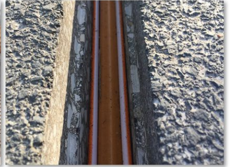
Stufenschlitzgraben mit Rohrverbund
