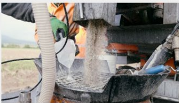
Ein modifiziertes Epoxidharz Bindemittel und Sand werden maschinell und voll automatisiert vermischt und danach umgetopft.
