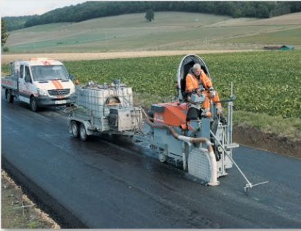
Schleifmaschine mit Auffangbehälter
