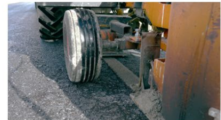
Abziehen des Verfüllmaterials
