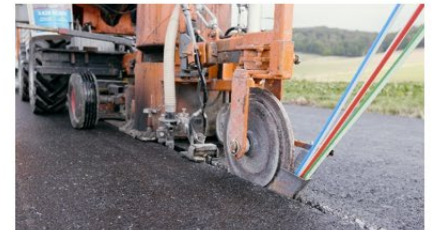
Einbringung der Rohrverbunde
